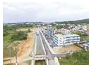
勢高排水路・2号線整備
