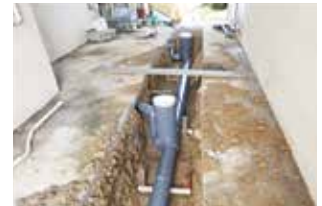
▲下水道宅内配管工事
