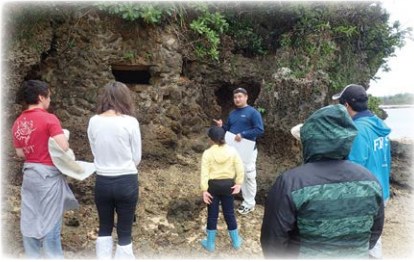
瀬良垣のトーチカ跡
