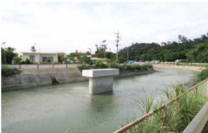
名嘉真川橋りょう整備工事
